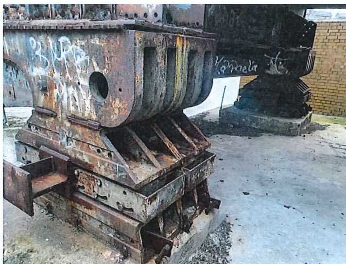
Fot. 21. łożysko południowe
