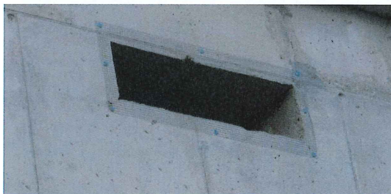
Fot. 2. Strona południowa – otwór 1 – siatka nieuszkodzona
