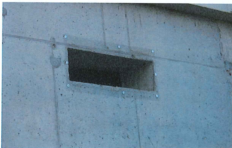
Fot. 11. Strona północna – otwór 4 – siatka nieuszkodzona
