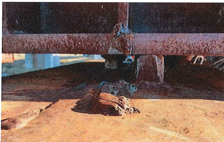
Fot. 18. Łożysko północne oczepu górnego przed konserwacją
