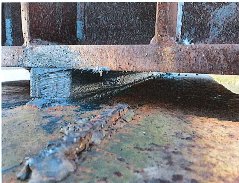
Fot. 17. łożysko południowe oczepu górnego po konserwacji
