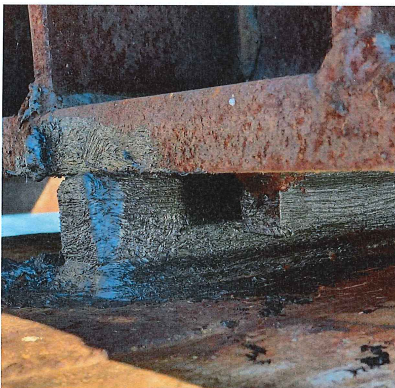
Fot.19. łożysko północne oczepu górnego po konserwacji
