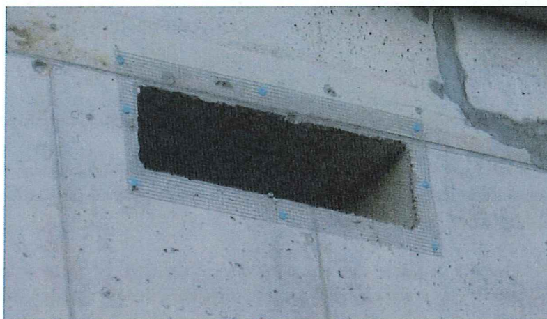
Fot.3. Strona południowa – otwór 2 – siatka nieuszkodzona
