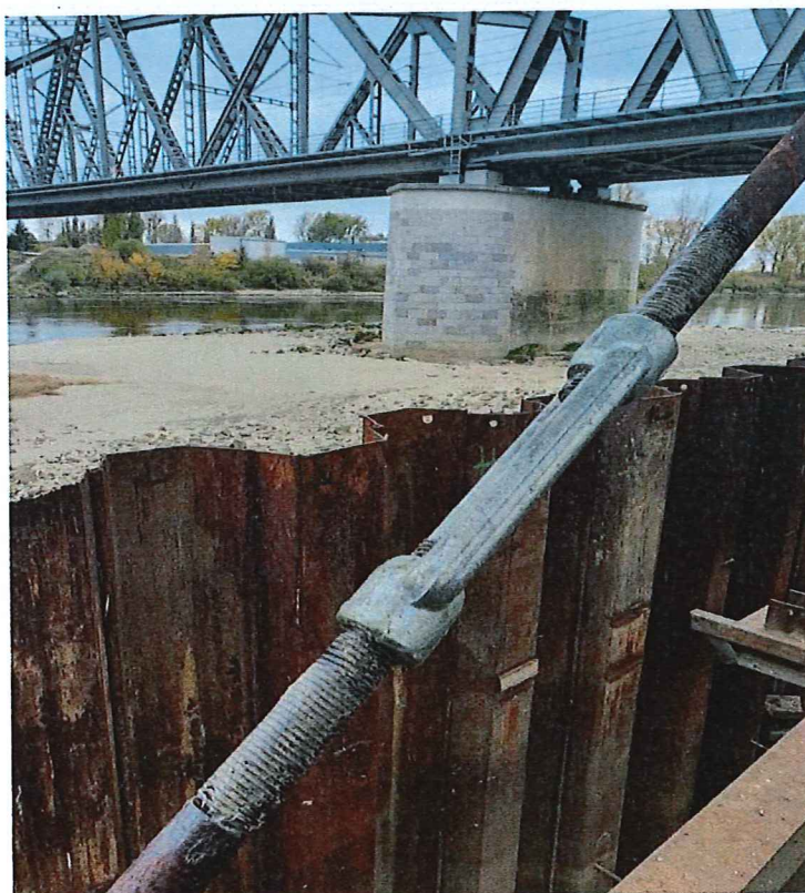
Fot. 14. Konserwacja – smarowanie śruby rzymskiej
