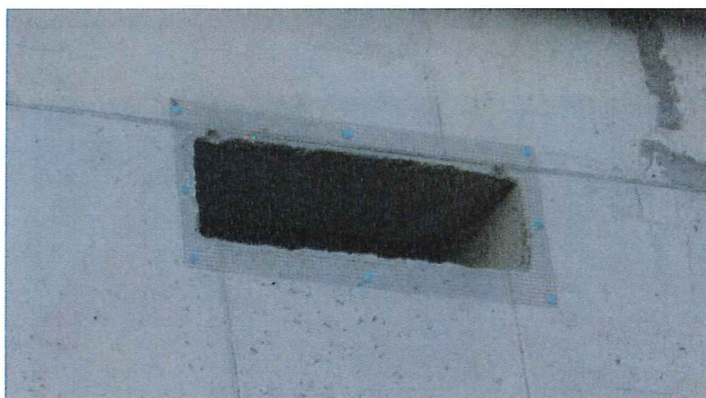
Fot. 4. Strona południowa – otwór 3 – siatka nieuszkodzona
