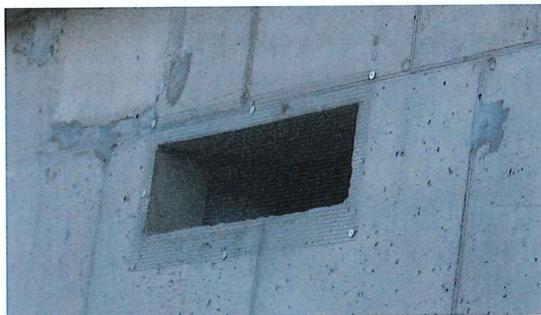
Fot. 8. Strona północna – otwór 1 – siatka nieuszkodzona
