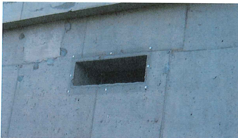
Fot. 9. Strona północna – otwór 2 – siatka nieuszkodzona
