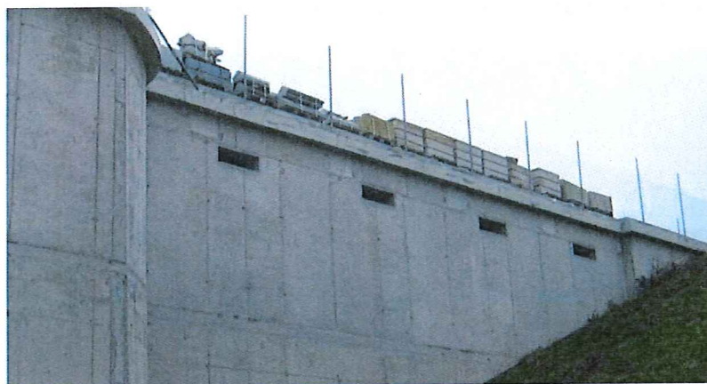
Fot. 7. Strona północna – 4 otwory wentylacyjne
