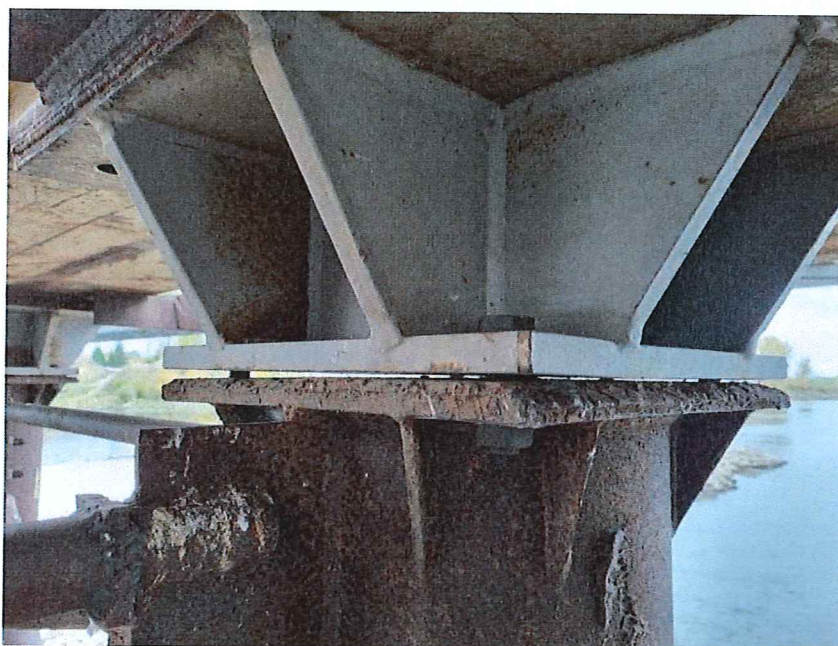
Fot. 15. Połączenie śrubowe niedokręcone
