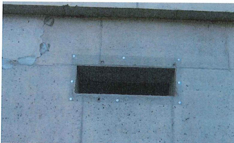
Fot. 10. Strona północna – otwór 3 – siatka nieuszkodzona
