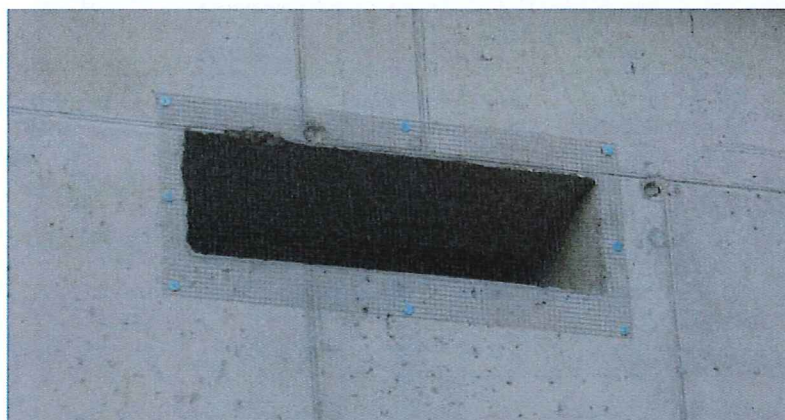
Fot. 5. Strona południowa – otwór 4 – siatka nieuszkodzona
