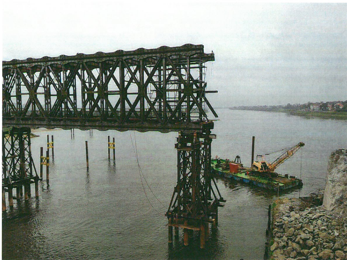
Fot. 3 – Stan istniejący mostu – widok od strony mostu kolejowego – widoczne podpory PT5 i PT6
