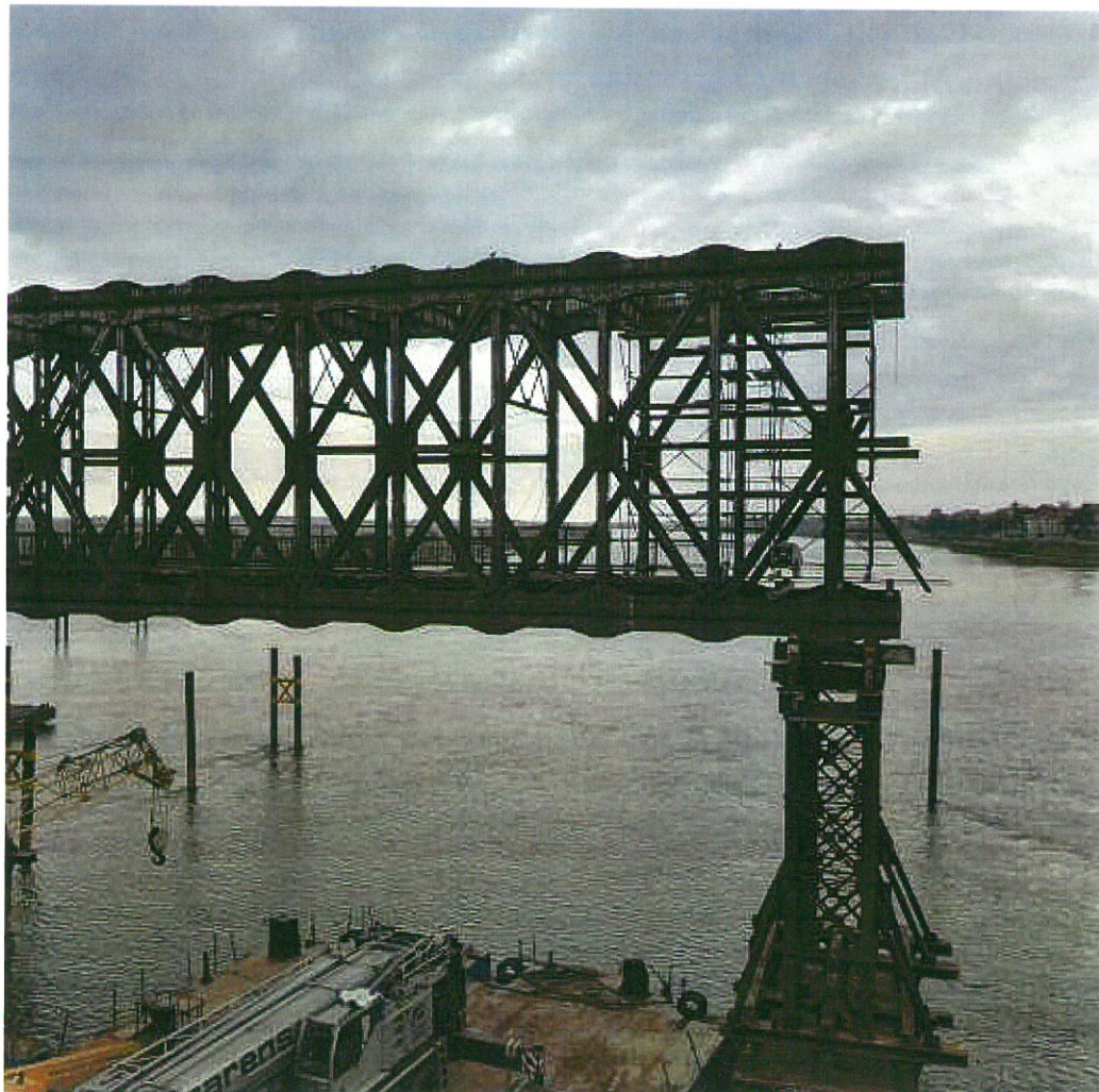
Fot. 1 – Stan istniejący mostu – koniec przęsła 2 oparcie na podporze PT5
