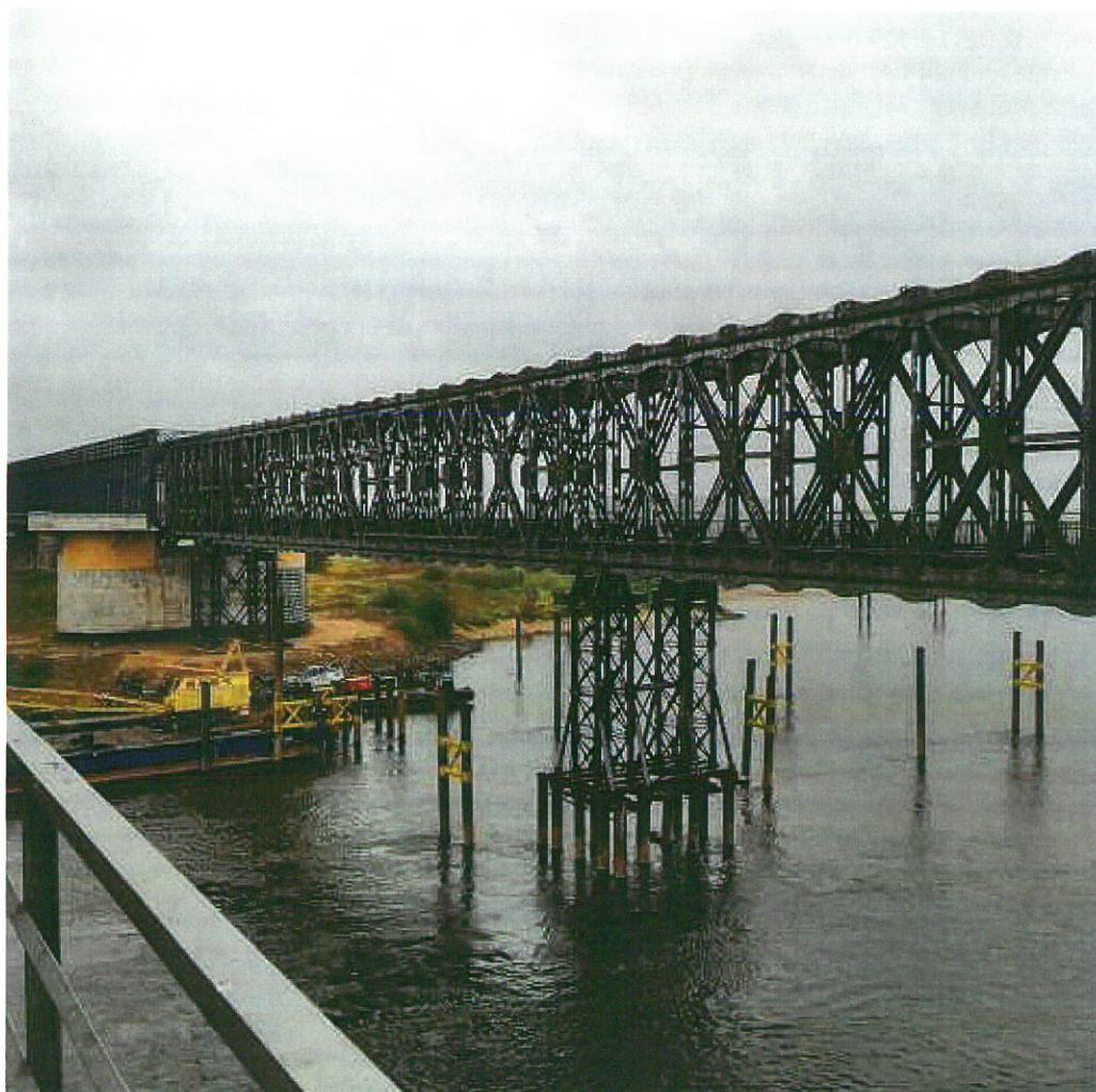
Fot. 2 – Stan istniejący mostu – przęsło nr 2 oparte na podporach PT6 i PT9
