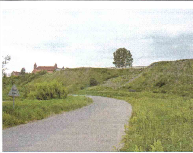
Fot.4. Widok na osuwisko od strony wschodniej.
